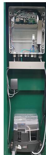
Intégré dans un poteau coffre avec commande déportée
